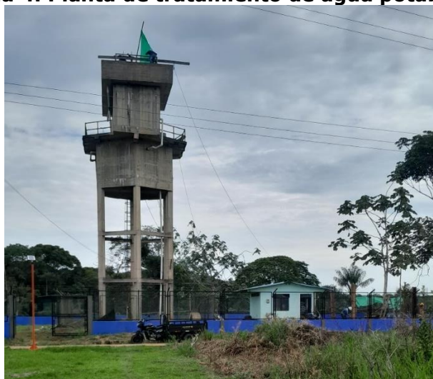
Fotografía 4. Planta de tratamiento de agua potable - PTAP
