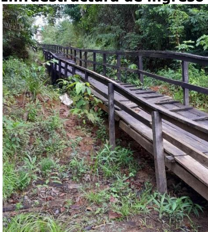
Fotografía 3. Infraestructura de ingreso a la captación
