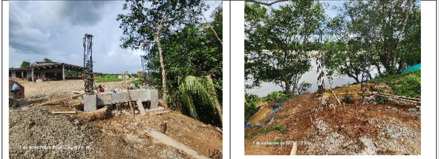
Durante el recorrido se evidencia la implementación del plan de contingencia con la apertura nuevos frente de obra (desarenador, filtración, cámara de contacto de cloro, instalación de postes de media tensión., lo que permitirá atenuar el atraso generado por falta de recursos financieros del contratista.
