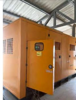
Fotografía 8: Generador de energía de emergencia
