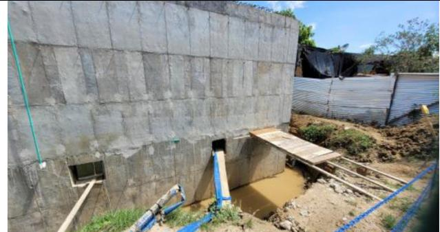
Fotografía 5: estructura EBAR, se identifica la infiltración agua alrededor de la estructura.
