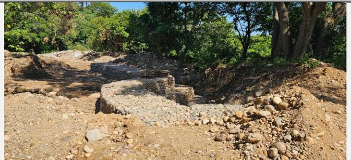
Descole colector aguas construcción de gaviones y rellenos para la protección del box Couvert en la parte final, aún falta adecuar la entrega al río Cesar en la ciudad de Valledupar.
