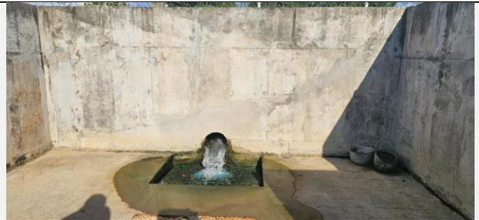
Ingreso de las aguas residuales a la PTAR, para inicio del tratamiento de las mismas en el sistema, con el fin de descontaminar estas aguas para su entrega y descarga al cauce natural de la zona.
