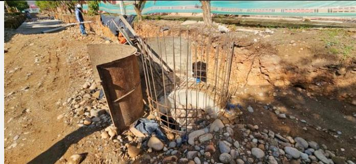
Pozo de inspección de colector de aguas lluvias en la zona urbana, objeto de intervención del proyecto. Calle 7B con carrera 8.
