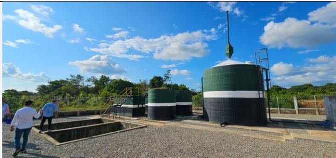
Sistema de tratamiento de aguas residuales donde se evidencia tanque con chimenea para liberación de gases, tanques de tratamiento anaerobio de las aguas residuales parte intermedia y tanques sedimentadores margen izquierda de la imagen y piscinas para mantenimiento del sistema.
