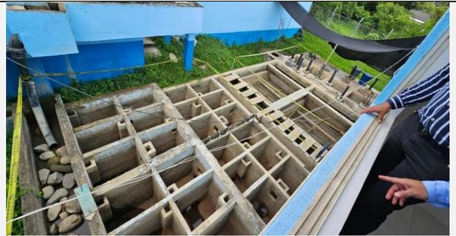
Zona de sedimentadores y filtros de la PTAP existente (vieja), la cual será optimizada con la adición presupuestal que se le realizó al proyecto por parte del municipio.
