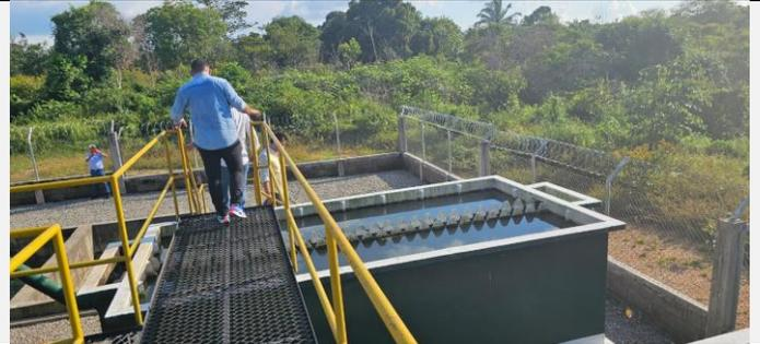
Tanque sedimentador para eliminar partículas granulares del agua residual para su posterior entrega al emisario final.
