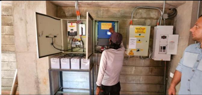
Operación del sistema eléctrico para el bombeo de agua potable al tanque elevado de la PTAP, donde se evidencia el sistema convencional para el suministro de energía en la parte derecha de la imagen y la parte izquierda se observa el sistema eléctrico para el sistema fotovoltaico.
