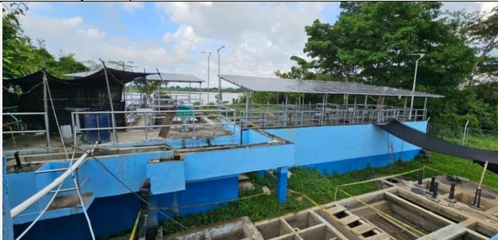
Vista general de la PTAP zona de sedimentación y filtros en el tratamiento del agua para volverla potable. En dicha zona se instalaron paneles solares para la operación de la planta con energía solar.
