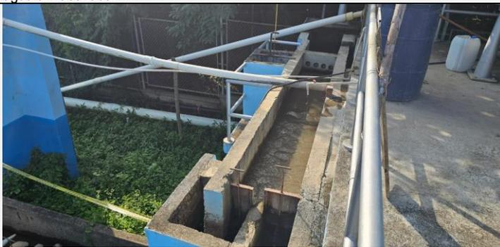
Canaleta Parshall para el control de caudal, donde inicia el proceso de potabilización del agua. Dicha canaleta será reemplazada por una en fibra de vidrio con los trabajos complementarios en la PTAP.
