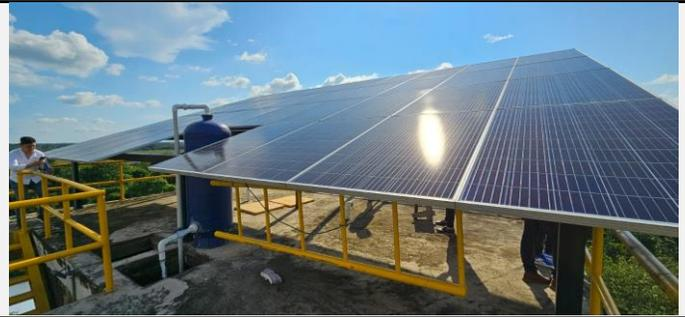
Paneles solares (sistema fotovoltaico) parte superior del tanque elevado en la PTAP, donde se puede evidenciar el bombeo y llenado del tanque.
