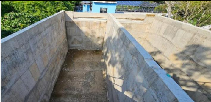
Tanque de almacenamiento agua cruda para su potabilización en la PTAP, el cual se distribuyó en dos celdas para operación y mantenimiento, lado izquierdo sin agua almacenada.
