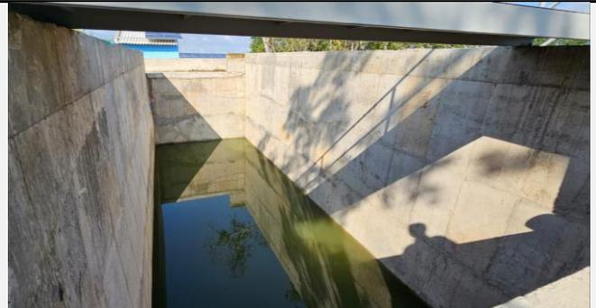
Tanque de almacenamiento agua cruda para su potabilización en la PTAP, el cual se distribuyó en dos celdas para operación y mantenimiento, lado derecho con agua almacenada para su potabilización.
