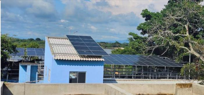
Paneles solares instalados en la PTAP para la operación de la misma y disminuir los costos del servicio de energía eléctrica.
