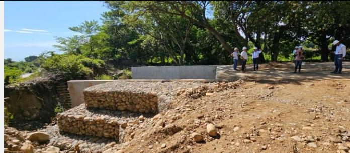
Zona de descole del colector de aguas lluvias con obras de protección de la obra con muro perimetral en gaviones y llenos con material del sitio.
