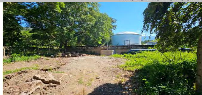
Tramo de Red de conducción HO de 20" que hace parte del alcance del CUR 1168 de 2021.
