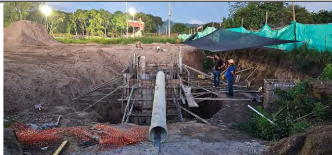
Vista general del sitio donde se ejecuta la EBAR por parte del municipio de El Copey – Cesar.
