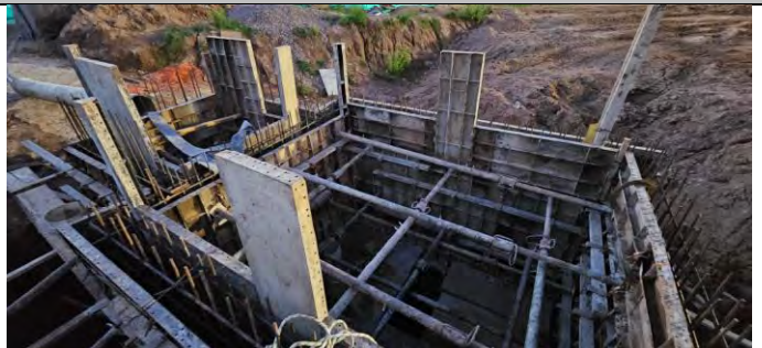
Entibados y encofrado para el vaciado de concretos en la construcción de la EBAR.
