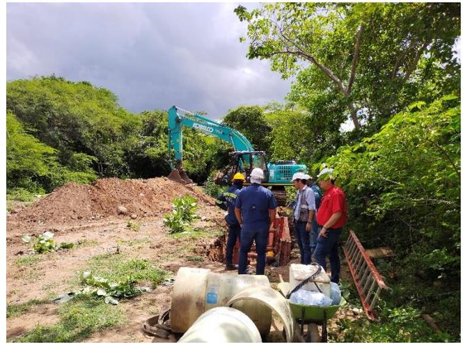
Durante el recorrido vehicular se observó otro frente de trabajo en la línea de conducción en e tramo entre el puente de El Silencio y el municipio de Distracción, en donde la instalación de la tubería se está haciendo una parte de la vía pavimentada, como se muestra en la imagen. Así mismo, se vio la adecuada señalización y el adecuado manejo del tránsito en la vía.
