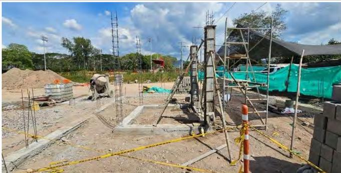
Vigas de cimentación cerramiento perimetral y caseta de operación, con aceros para la construcción de columnas de confinamiento de los muros a construir en la caseta de operación y el cerramiento perimetral a la EBAR.
