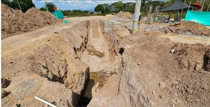
Excavación para conexión de pozo de alcantarillado a la estación de bombeo de agua residual que ejecuta el municipio de El Copey.
