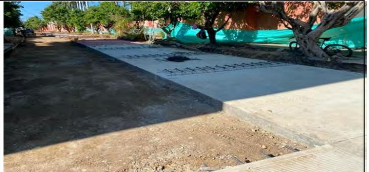
Losas de pavimento rígido construidas en el área urbana del municipio de Valledupar, después de construido el colector aguas lluvias (Box Coulvert).
