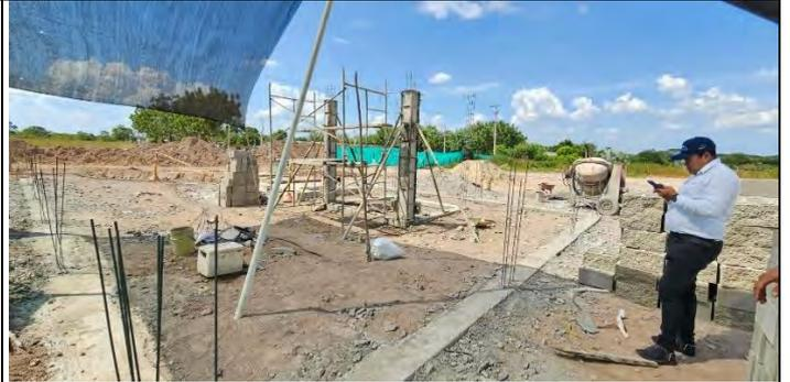
Se evidencia la nivelación de los rellenos alrededor de la estructura EBAR y el inicio de construcción del cerramiento perimetral y la caseta de funcionamiento (Cuarto electromecánico de operación).
