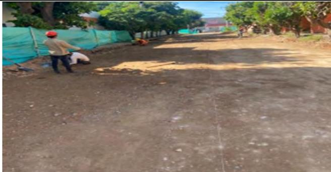
Instalación y cereo de material granular una vez construido el Box Coulvert, para posterior construcción de losas de pavimento rígido como capa de rodadura vial.
