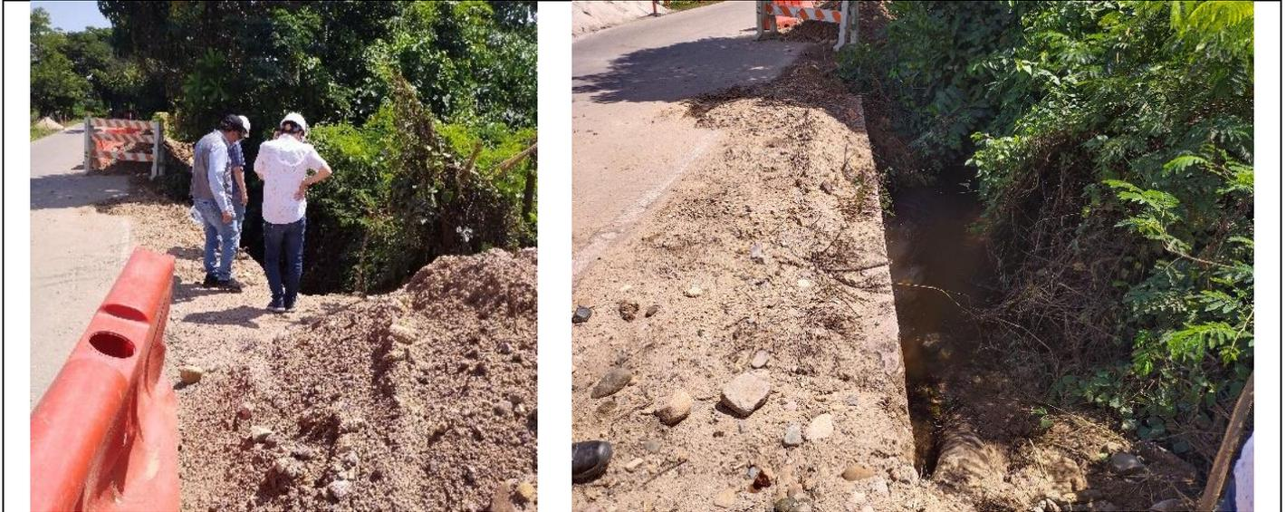
En el tercer y cuarto frente de obra, de las redes menores, se identificó la instalación de tubería de 6". En las zonas de trabajo se identificó la caseta, la señalización y el trabajo adecuado del contratista de obra.
