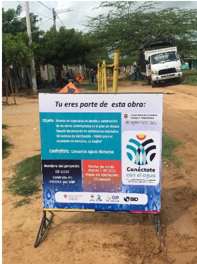
Inicio instalación tubería de refuerzo en la Comuna 10 – sector la Luchita (S6)
