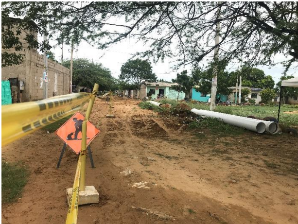
Inicio instalación tubería de refuerzo en la Comuna 10 – sector la Luchita (S6)
