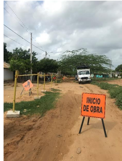
Inicio instalación tubería de refuerzo en la Comuna 10 – sector la Luchita (S6)
