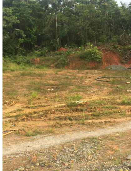
Imagen – Construcción de área para aprovechamiento de residuos
