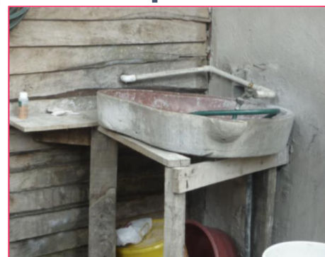
Ausencia de lavamanos
