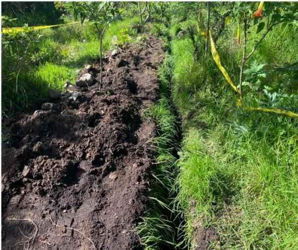
Excavaciones para instalación de tubería de aducción PEAD. 2"
