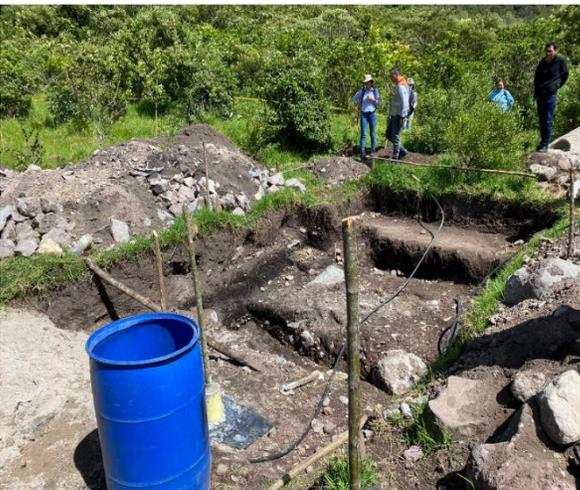
Excavaciones para tanque desarenador
