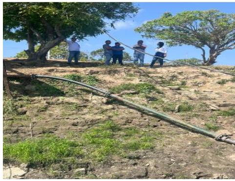
Fotografía 2. Línea de aducción con dos ampliaciones de 5 metros para el municipio de San Cristobal.
