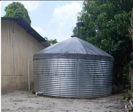
Ilustración 38 Tanque de almacenamiento scall
