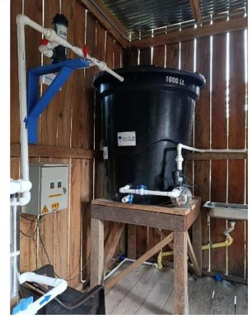
Ilustración 12 Unidad de cloración y tanque de almacenamiento.
