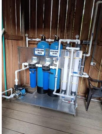
Ilustración 11 Unidad de tratamiento con filtración
