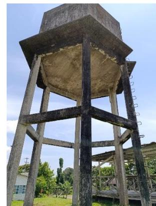
*Ilustración 25 Tanque de almacenamiento comunitario ( no opera filtraciones de agua)*
