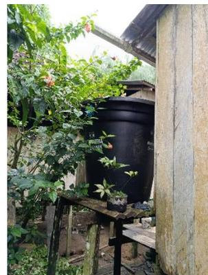
*Ilustración 3 Sistema de aguas lluvias familiar*
