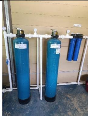
Ilustración 39 Filtración Scall
