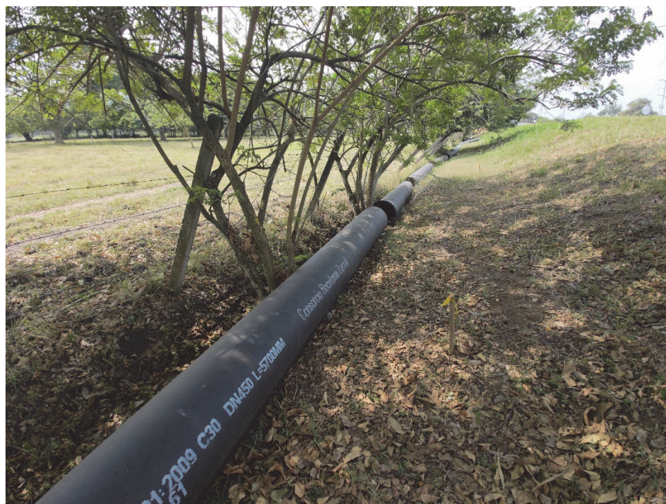
Tubería dispuesta en sitio frente 1
