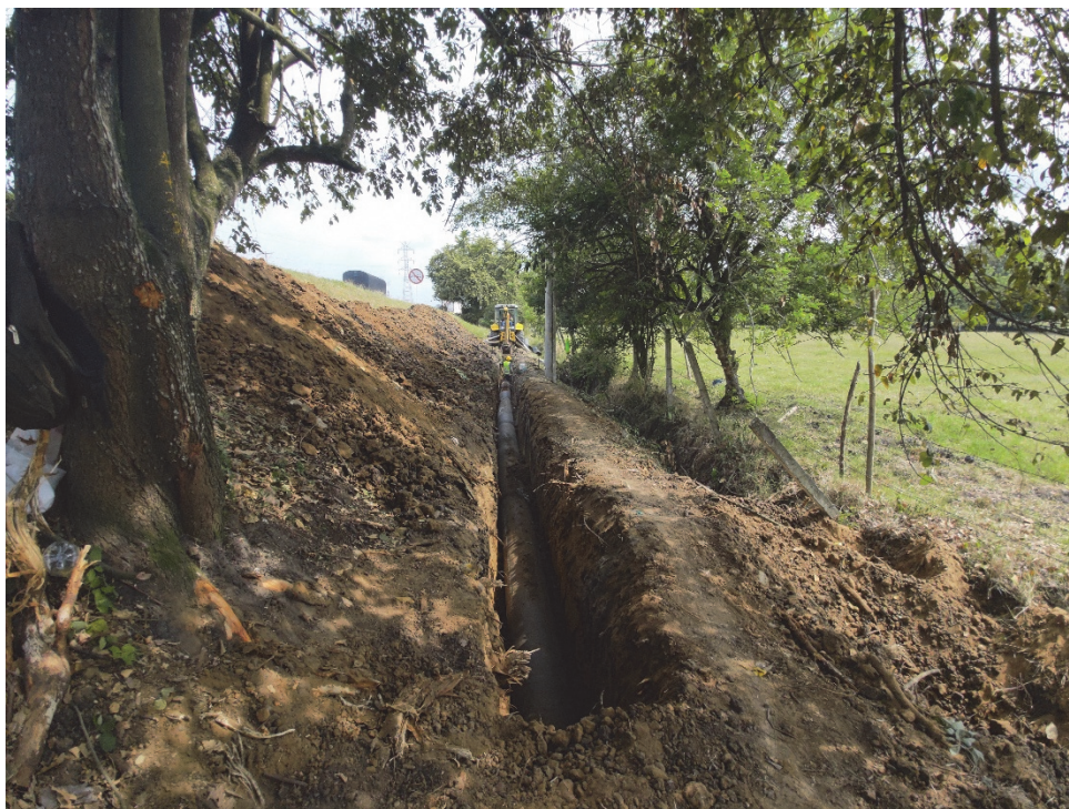
Tubería en proceso de instalación (frente 1)
