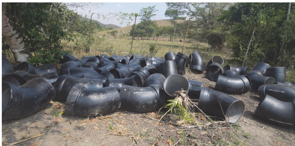
Registro fotográfico codos 22° dispuestos en sitio de acopio zona de la bocatoma
