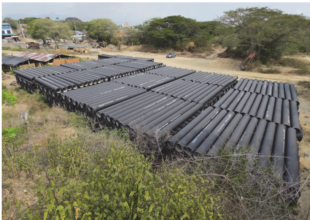
Registro fotográfico tubería dispuesta en sitio por parte del contratista 1.005 unidades
