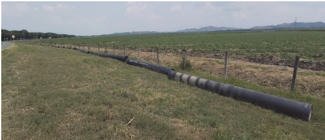
Tubería dispuesta en sitio frente 2
