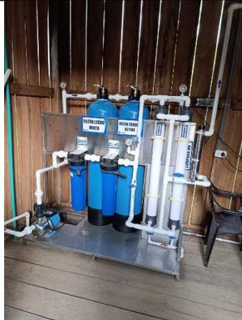
Ilustración 17 Unidad de tratamiento con filtración
