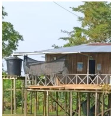
Ilustración 51 Sistema de aguas lluvias familiar
