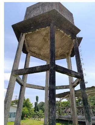
*Ilustración 31 Tanque de almacenamiento comunitario ( no opera filtraciones de agua)*
