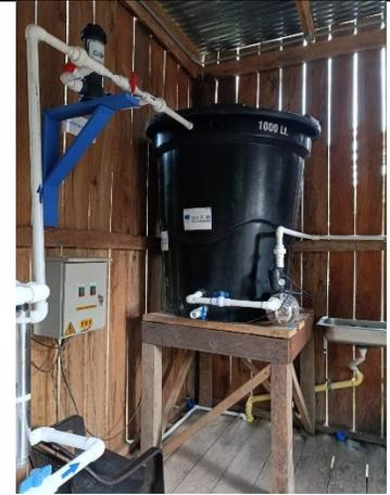
Ilustración 18 Unidad de cloración y tanque de almacenamiento.
