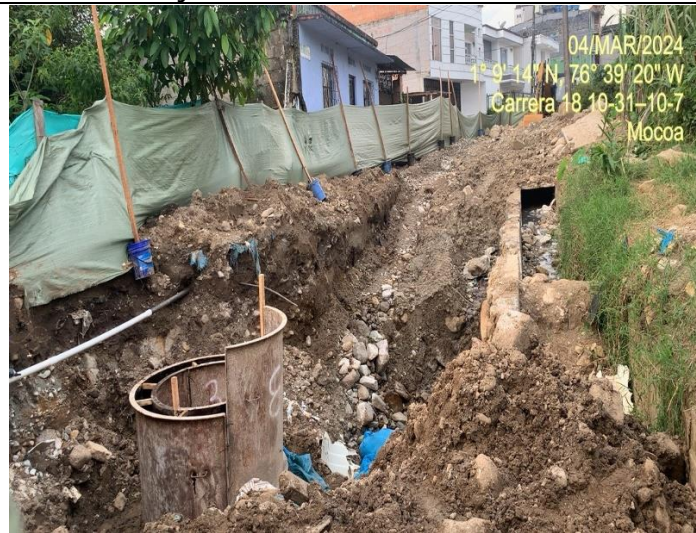
Tramo box coulvert en intervención
