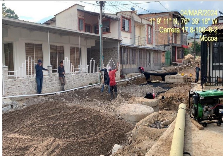
Tubería instalada, pavimentación por parte de la Alcaldía
