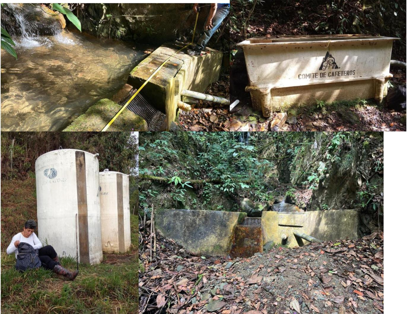
Respecto a las estructuras, se evidenció que los tanques y el desarenador no cuentan con la capacidad mínima con la cual garantizar el correcto funcionamiento del sistema, a pesar de que no están en mal estado, razón por la cual se realizará la reconstrucción de estas dos estructuras.
