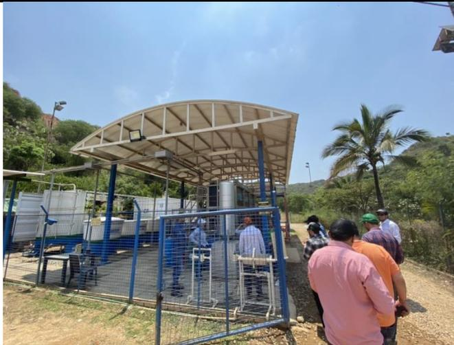
**Fotografía 8.** Planta de osmosis inversa para tratamiento de lixiviados.
