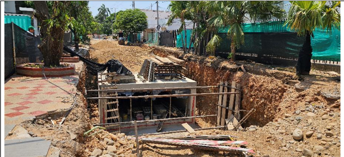
Construcción de Box Coulvert, en la calle 7B entre carreras 7 hacia la 8.
