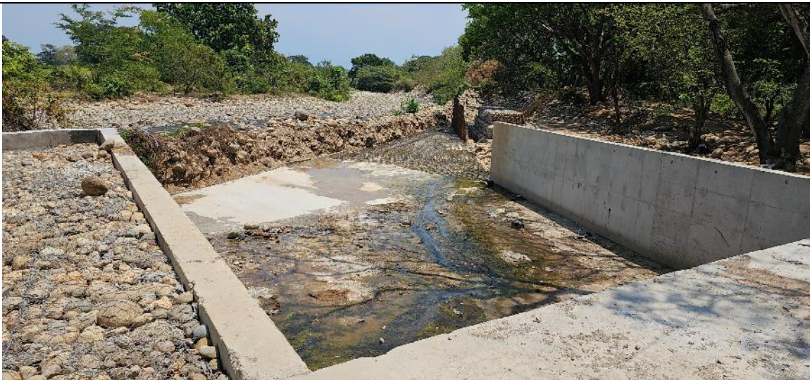
Obras canal de descole del colector de aguas lluvias al rio Guatapurí en la ciudad de Valledupar.
