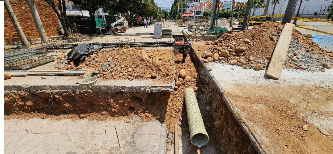
Construcción de sumideros transversales en la bocacalle de la carrera 8 con calle 7B, los cuales depositaran las aguas lluvias al Box Coulvert que pasa por la Calle 7B.
