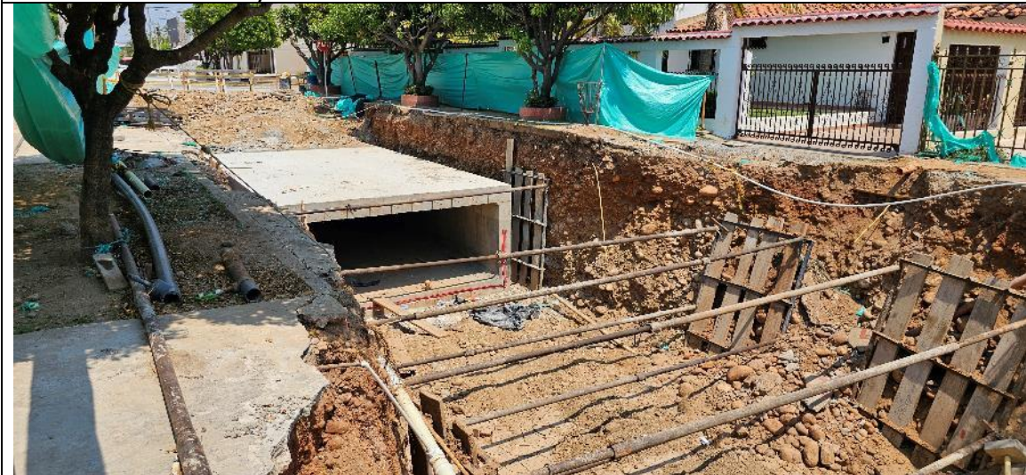
Obras en construcción en la Calle 7B entre Carreras 12 y 13.
