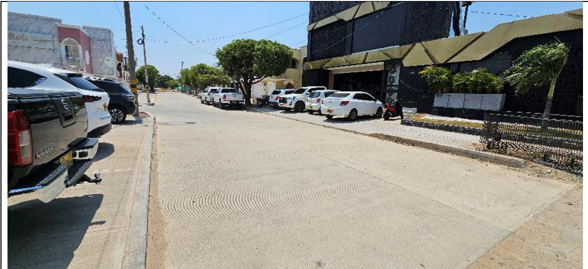
Obras de colector ya construidas en la Calle 7B entre carreras 9 a la 12.
