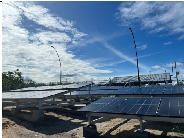
Páneos solares que brindar energía al sistema de acueducto del Remanso.
