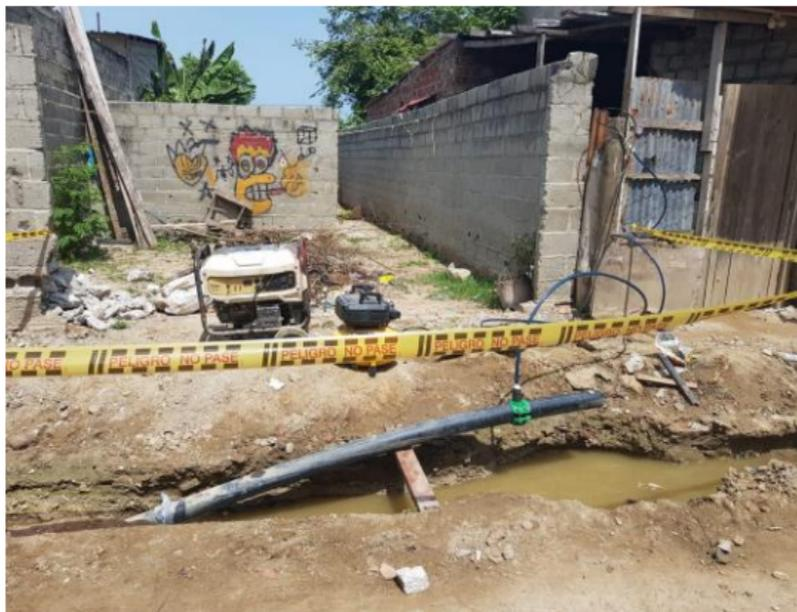
Llenado de tubería PEAD para prueba hidrostática
