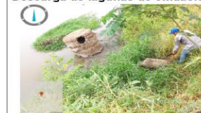
Descarga de lagunas de oxidación
