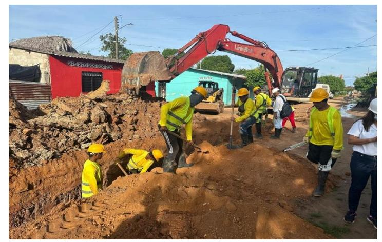
**Excavaciones – Suministro e instalación de redes de alcantarillado sanitario (13-06-2024).**
