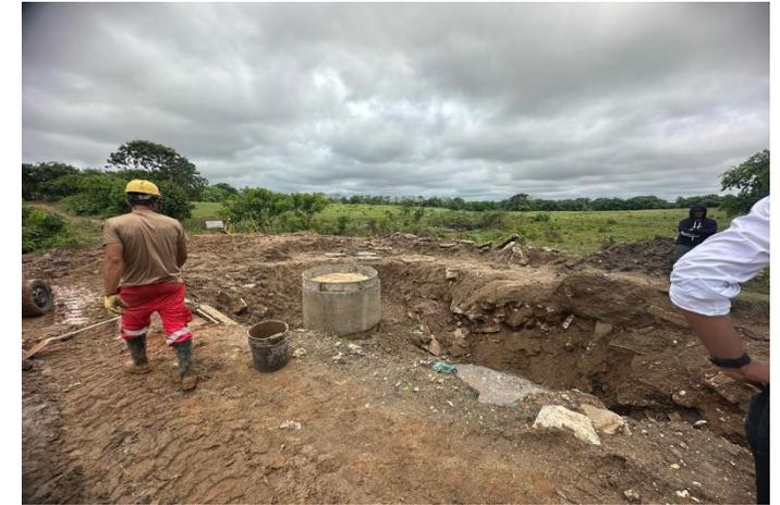
Excavaciones - suministro e instalación de redes alcantarillado - Construcción de pozos de inspección
