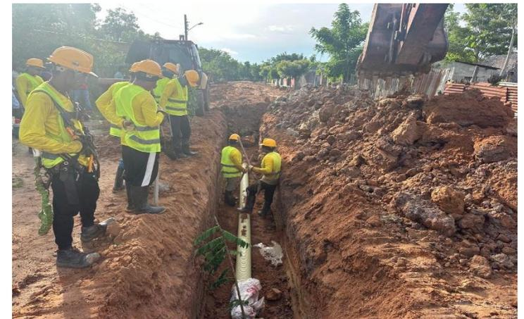
**Excavaciones – Suministro e instalación de redes de alcantarillado sanitario (13-06-2024).**
