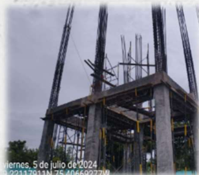
FUNDIDA DE COLUMNAS DEL TERCER AL CUARTO NIVEL DEL TANQUE
