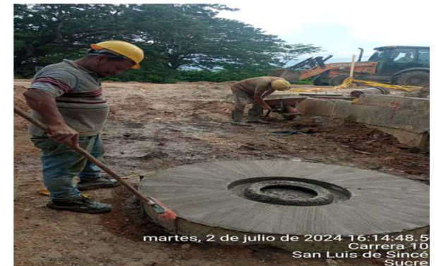
Excavaciones y rellenos - Construcción de pozos de inspección.
