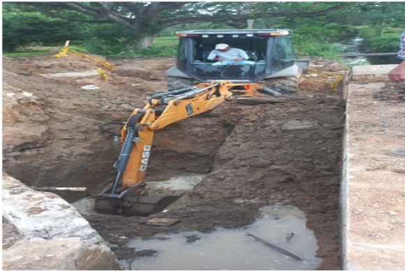
Excavaciones - Suministro e instalación de redes alcantarillado - Retiro de material sobrante
