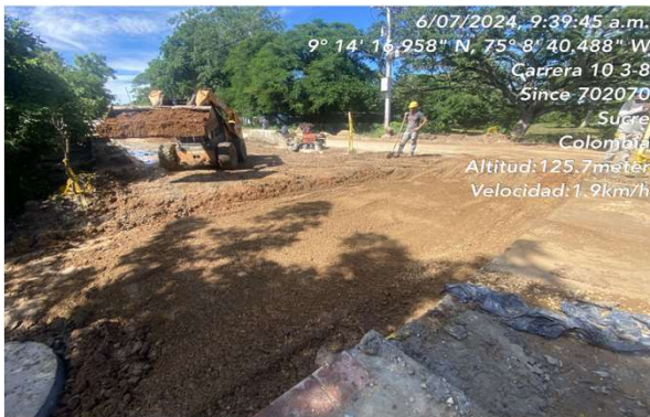
Excavaciones - Suministro e instalación de redes alcantarillado - Retiro de material sobrante
