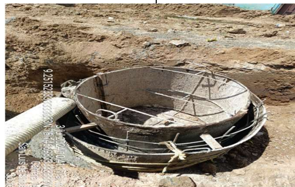
Excavaciones y rellenos - Construcción de pozos de inspección.
