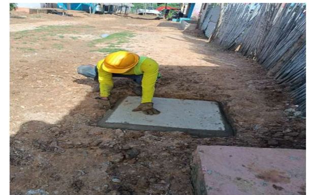
Construcción de pozos de inspección y acometidas domiciliarias.
