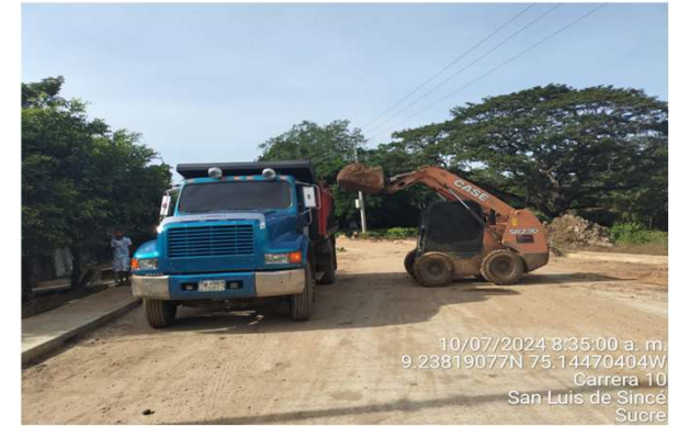
Excavaciones - Suministro e instalación de redes alcantarillado - Retiro de material sobrante
