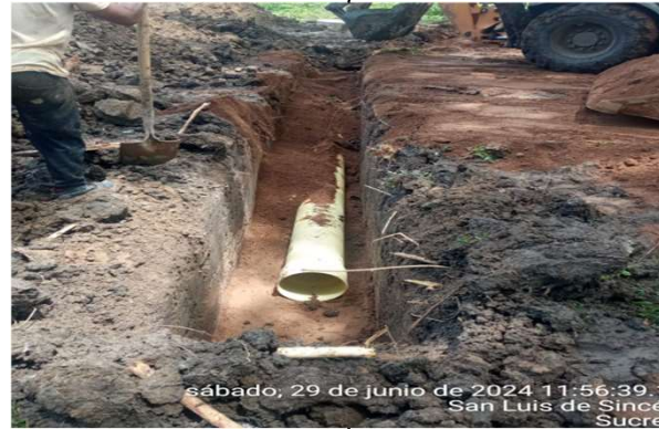
Excavaciones - Suministro e instalación de redes alcantarillado - Retiro de material sobrante
