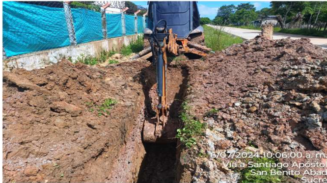
Excavaciones – Suministro e instalación de redes de alcantarillado sanitario.
