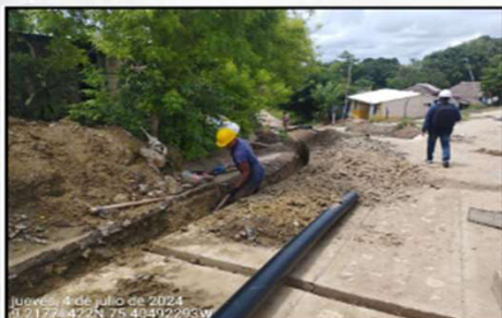
EXCAVACIONES E INSTALACIÓN DE TUBERÍA EN EL TRAMO DE LA PLACA HUELLA
