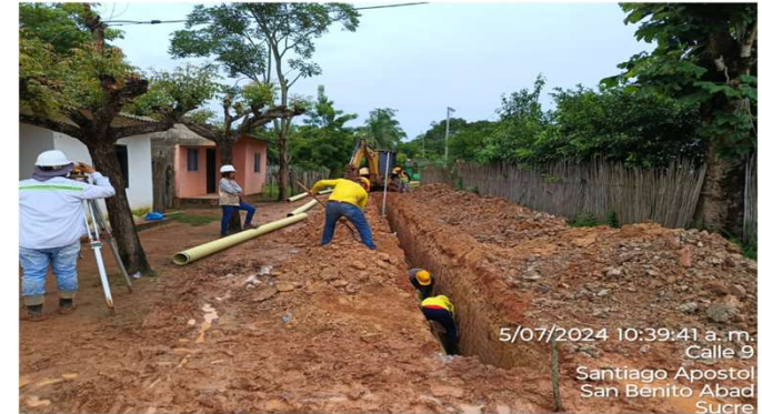
Excavaciones – Suministro e instalación de redes de alcantarillado sanitario.
