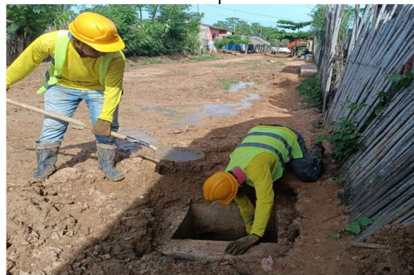
Construcción de pozos de inspección y acometidas domiciliarias.
