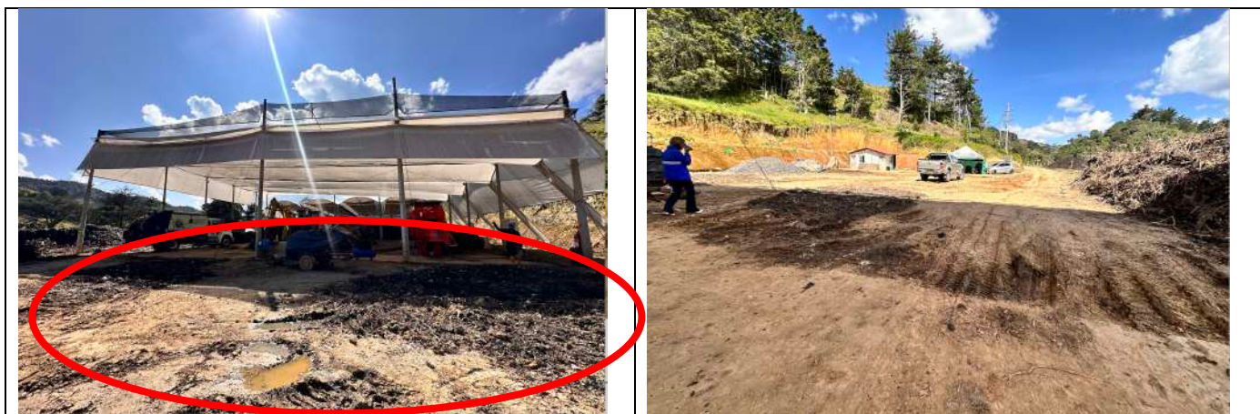
Imagen 4. Área disponible para localización de equipos
