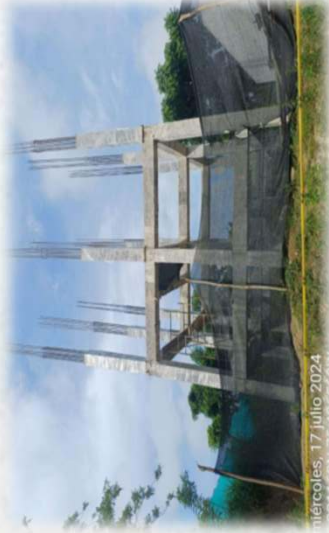
DESENCOFRADO DE LAS COLUMNAS DEL TERCER NIVEL DEL TANQUE
