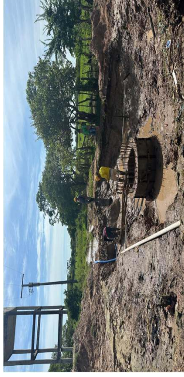
Construcción de pozos de inspección. (fecha del registro 02-08-2024).
