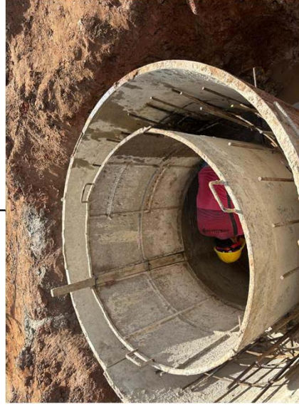
Excavaciones – Construcción de pozos de inspección y acometidas domiciliarias. (fecha del registro 02-08-2024).
