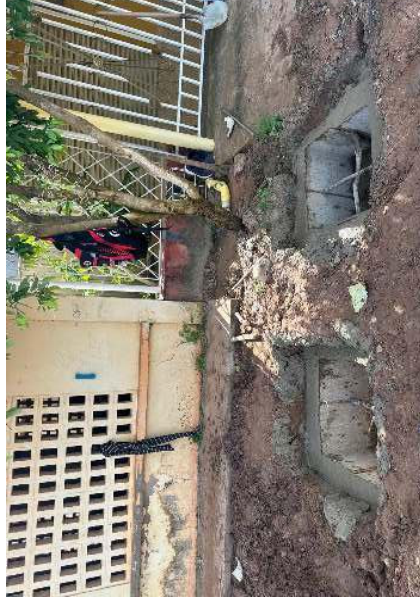
Excavaciones – Construcción de pozos de inspección y acometidas domiciliarias. (fecha del registro 02-08-2024).
