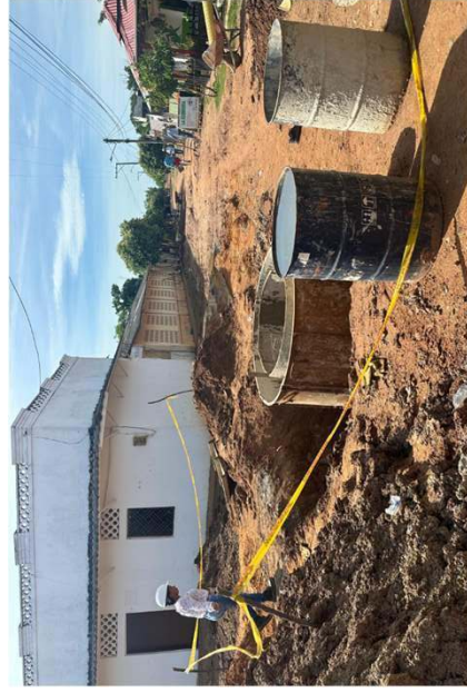
Excavaciones – Construcción de pozos de inspección y acometidas domiciliarias. (fecha del registro 02-08-2024).
