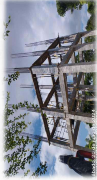
ARMADO DE FORMALETAS PARA INICIAR LA INSTALACION DEL ACERO DE LAS VIGAS DEL CUARTO NIVEL
