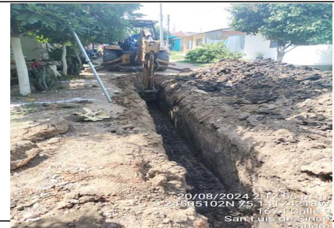
Excavaciones - Suministro e instalación de redes alcantarillado – Construcción de pozos de inspección.
