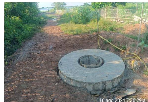
**Excavaciones – Construcción de pozos de inspección. (fecha del registro 16-08-2024).**
