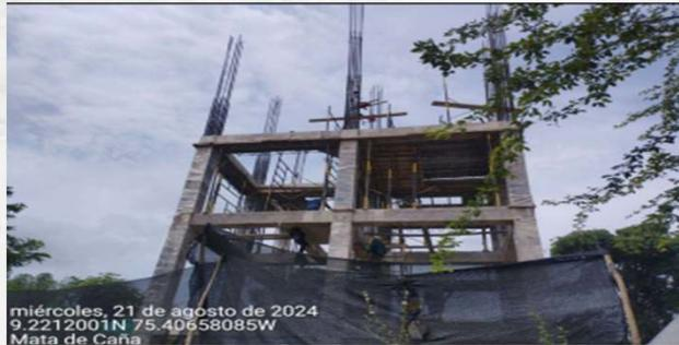
ARMADO DE ACERO DE LAS COLUMNAS DEL CUARTO AL QUINTO NIVEL
