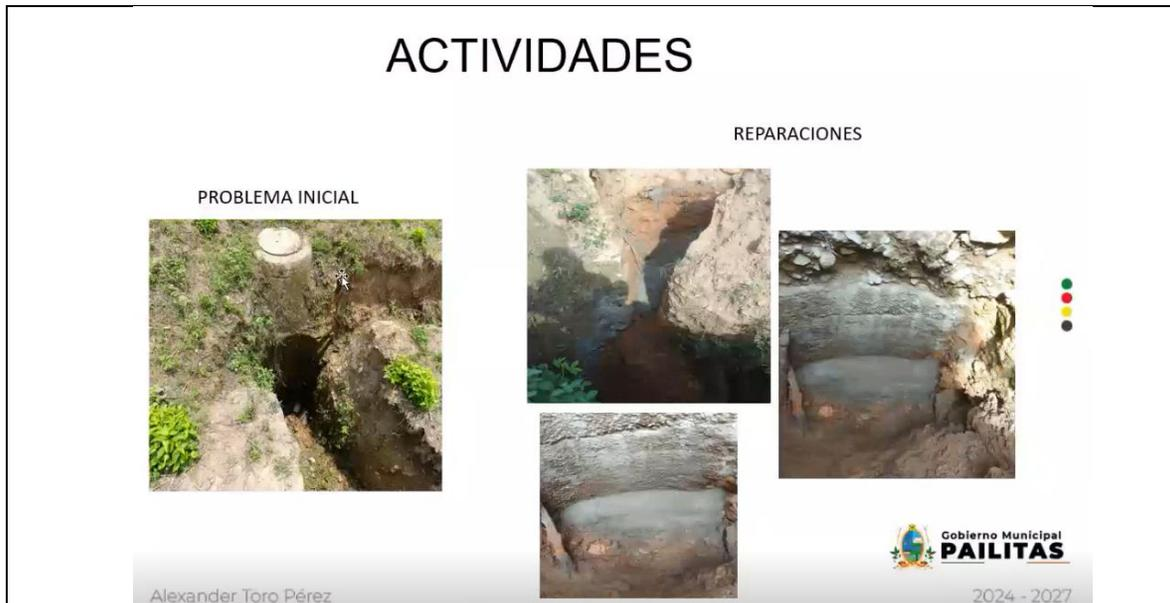
En la imagen se evidencia el daño que tenía uno de los pozos de alcantarillado, el cual fue sellado y reparado para evitar el ingreso de aguas de escorrentía y material de arrastre en temporada de lluvias.
