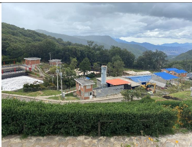
Fotografía 10. Plantas de tratamiento de lixiviados y de biogás en el parque tecnológico y ambiental ANTANAS-Pasto. Fuente MVCT 09-09-2024
