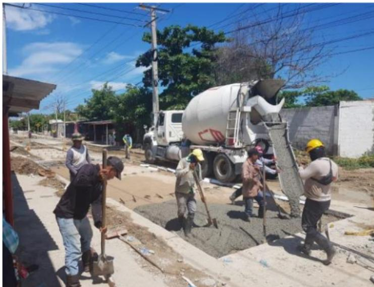
Concreto rígido para pavimento.
