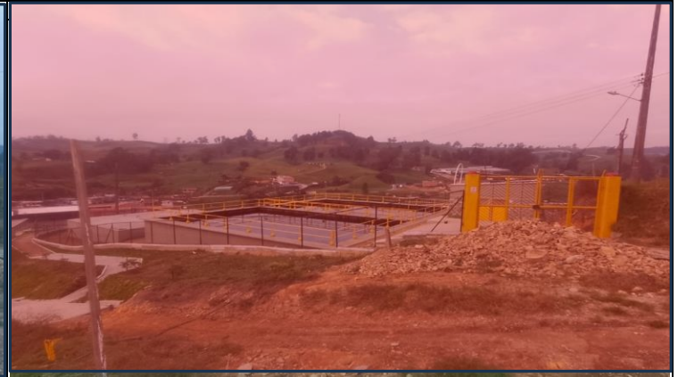
AVANCE DE OPTIMIZACIÓN DE LA PLANTA DE TRATAMIENTO DE FILTRACIÓN LENTA EN ARENA (ARENA Y DESINFECCIÓN)
