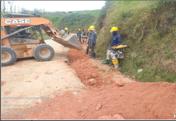
FOTO 10 Trabajos de instalación y lleno compactado mecánicamente, vía sector Las Brisas, cerca a la finca "La Leona".
