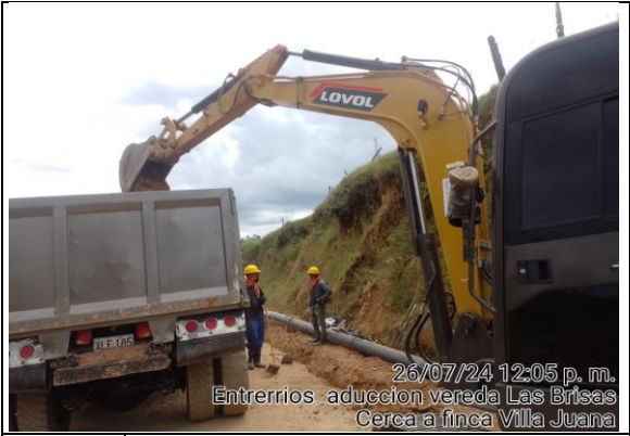
FOTO 9 Trabajos de instalación de tubería PEAD 10", en inmediaciones de la finca "Villa Juana"
