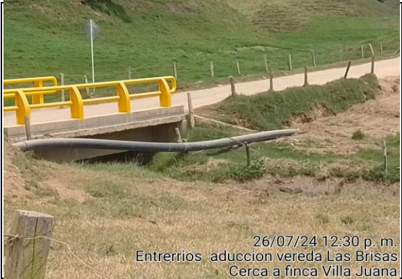
FOTO 7 Instalación de tubería PEAD 10", en la vía que conduce a la vereda "Las Brisas", se instaló tubería para pasar el puente, en este punto se requiere construir viaducto.
