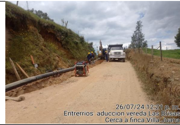
FOTO 8 Trabajos de termo fusión en tubería PEAD 10" e instalación de la misma, en el tramo que va por la vía a Labores, sector vereda "Las Brisas", Km 8 + 990.
