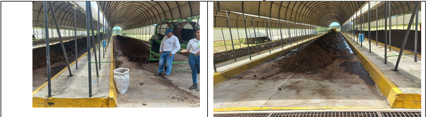
Imagen Planta de tratamiento de orgánicos
