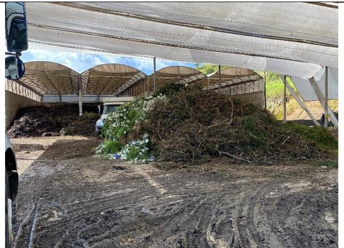
**Fotografía 18.** Visita planta de compostaje del municipio de La Ceja-Antioquia. Proceso de triturado y al fondo los biodomos que funcionan con aireación forzada. Fuente MVCT 01-10-2024
