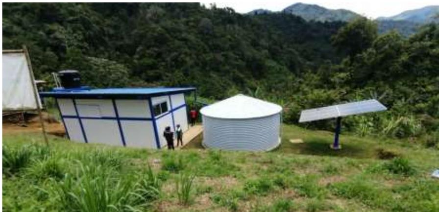
**Fotografía 8.** Sistema de Captación de Aguas Lluvia (SCALL) Resguardo unificado GITO DOKABÚ, vereda Paparidó
