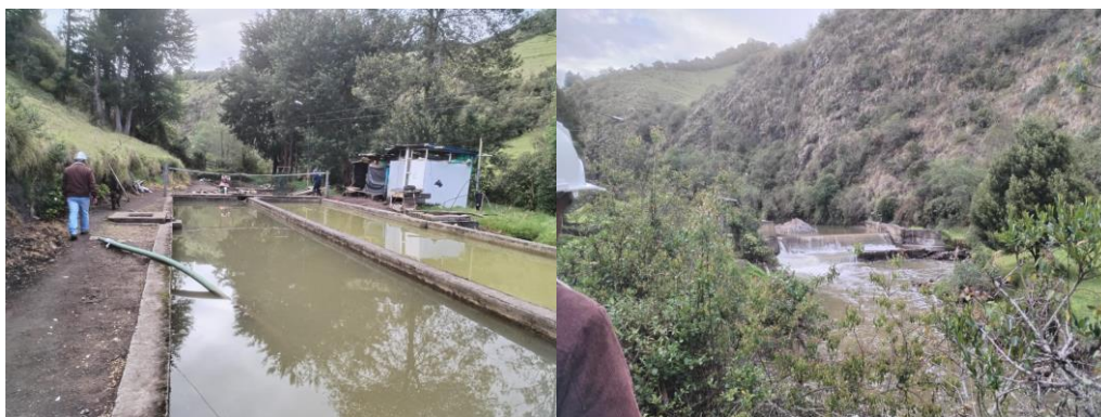
Fotografías de la zona de la bocatoma y desarenadores del sistema de acueducto de Ipiales
