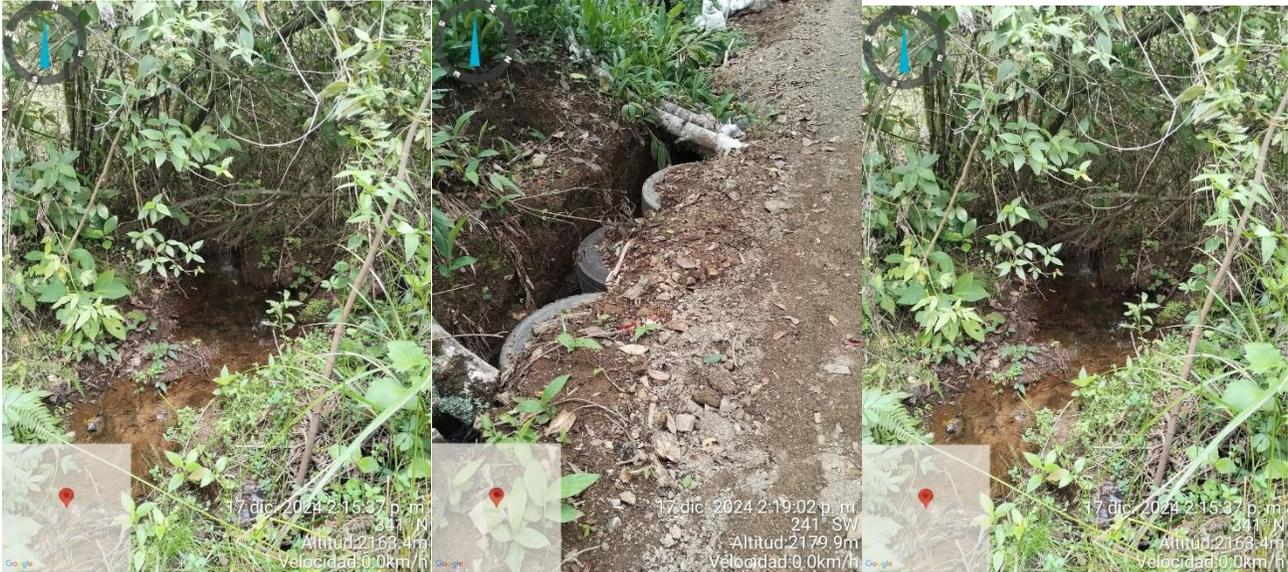
Se identifica el desarenador que actualmente tienen la comunidad, el cual está fuera de servicio, no tienen conexión hidráulica con la bocatoma, además se encuentra aguas arriba de esta estructura.
