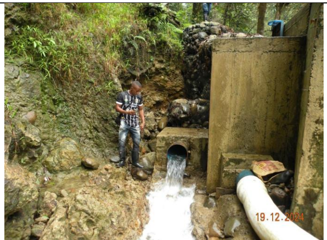
Foto No. 8 Salida al desarenador y desagüe
