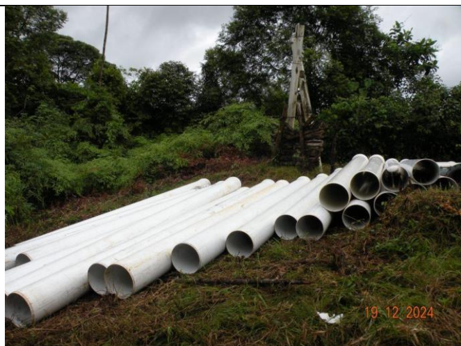
Foto No. 4 Acopio de tubería
