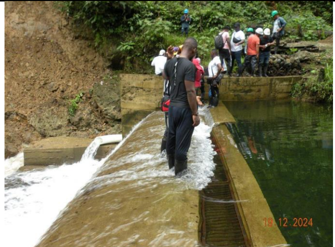
Foto No. 10 Vista de la bocatoma hacia la orilla derecha
