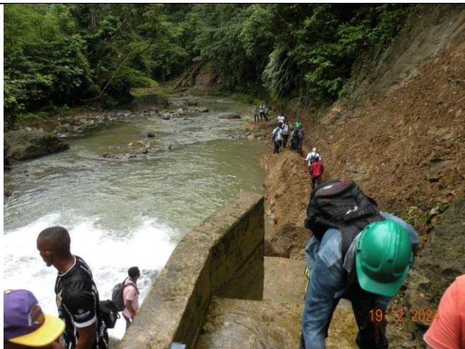
Foto No. 11 Excavación para aducción orilla derecha.
