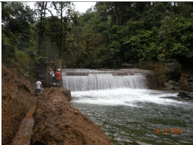
Foto No. 7 Vista de la bocatoma
