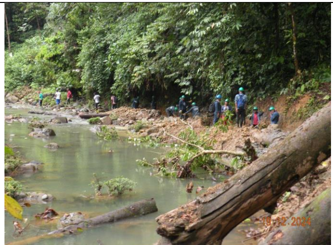
Foto No. 12 Vista de la bocatoma hacia orilla derecha
