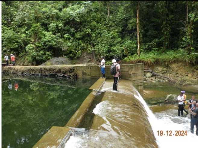
Foto No. 9 Vista de la bocatoma hacia la orilla izquierda
