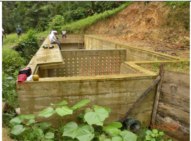
Foto No. 14 Vista del desarenador hacia aguas abajo
