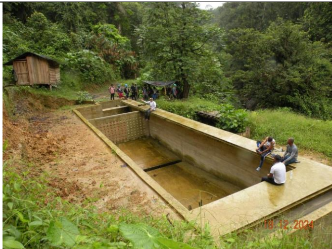
Foto No. 13 Vista del desarenador hacia aguas arriba
